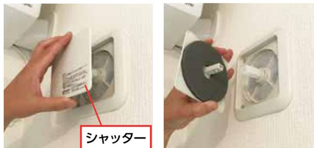
シャッターの中央部を数回押しして全開にし、シャッターを手前に引くと外れます。
